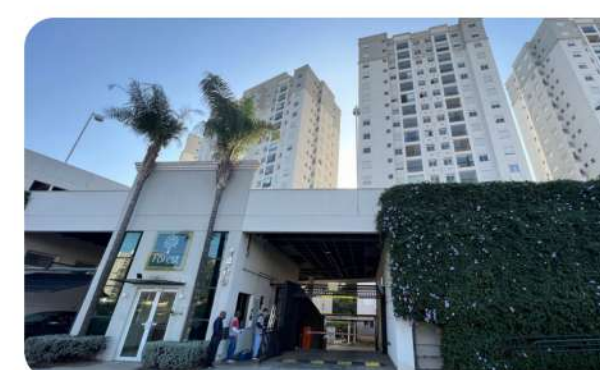
COND. ED. FOREST Inspeção estrutura e umidade
