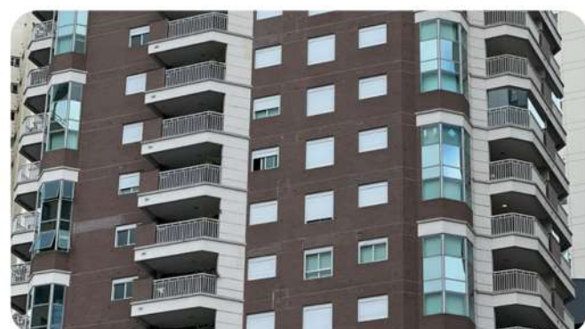
ED. ESTANCONFOR Inspeção de fachada
