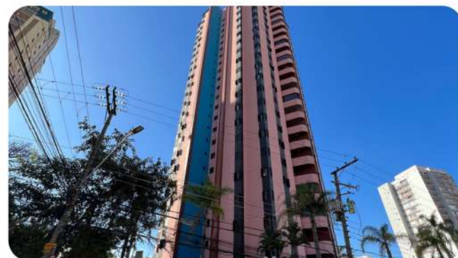
PIAZZA DELLA FONTANA Inspeção de fachada
