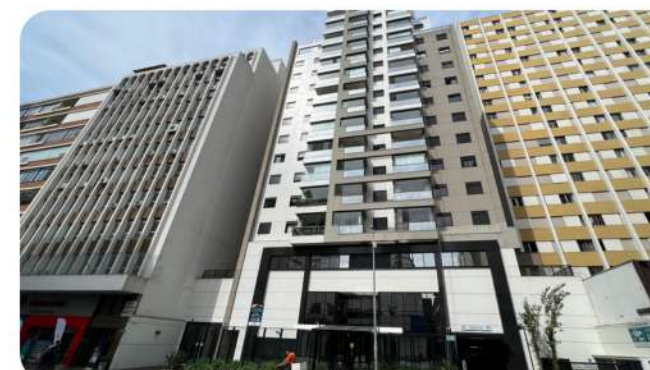
COND. ED. JUST BRIGADEIRO Manutenção das fachadas
