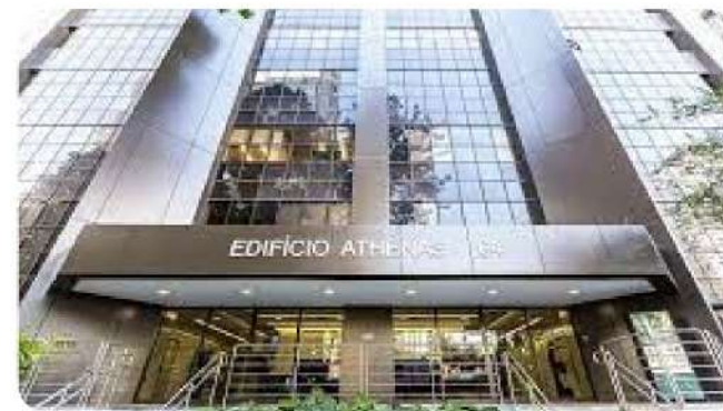
COND. ED. ATHENAS Consultoria Técnica
